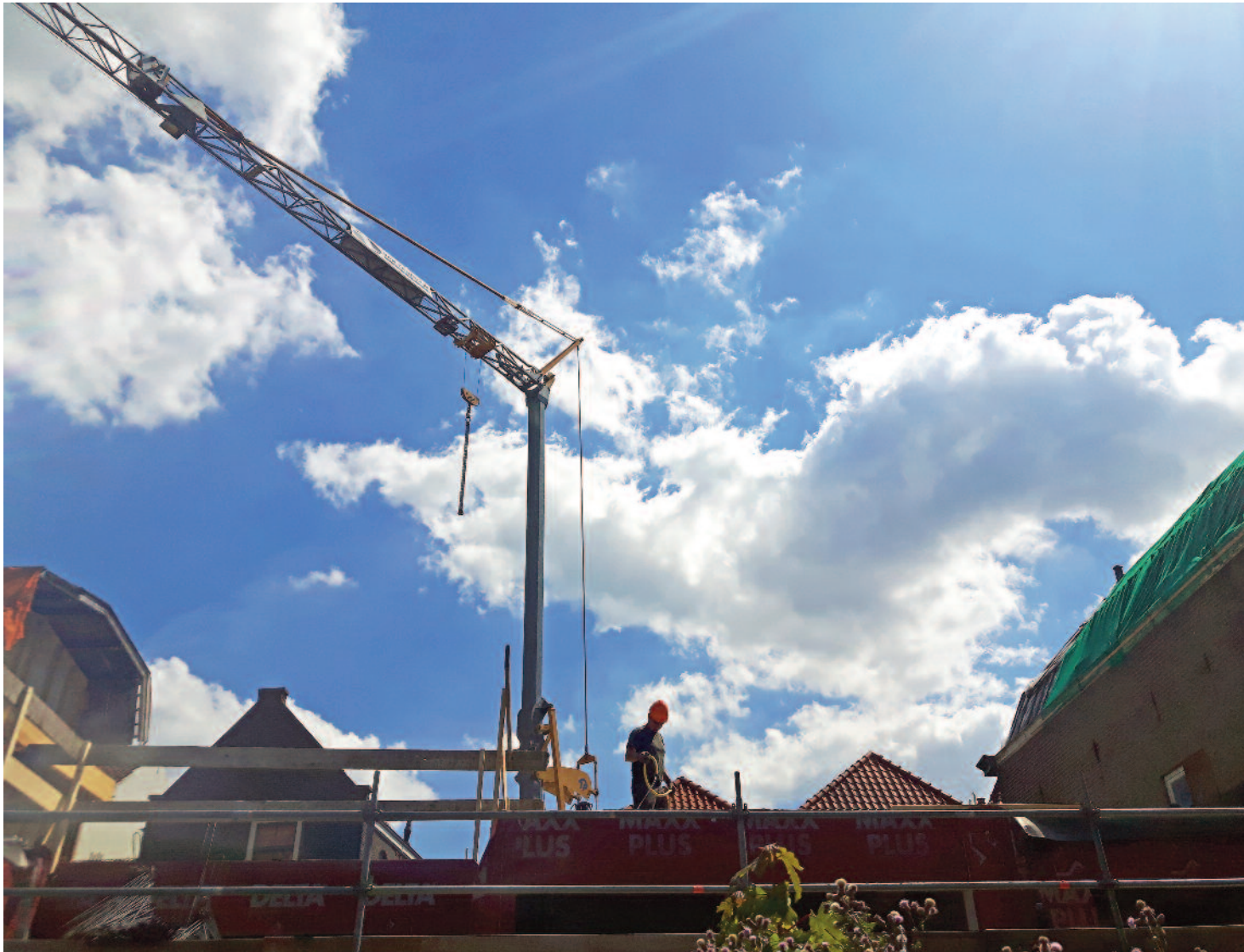
⤴ De aannemer en zijn kraan. Een beeld dat in de zomermaanden van 2018 de Hazewindhondstraat domineert.
